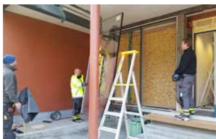
Rehabilitering av inngangspartiet ved Eresfjord barne- og ungdomsskule. ▶
